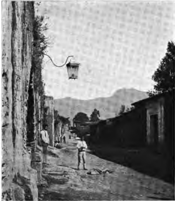
Vorstadtstrasse bei der Wasserleitung
